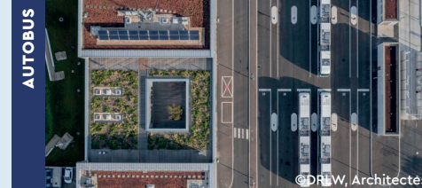
Site de maintenance et remisage Corbeil-Essonnes (91)
