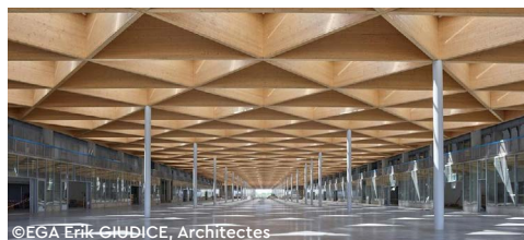
Construction du Marché d'Intérêt National de Nantes – Rezé (44) – 108 M€ HT
