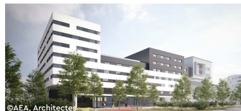
Construction de 45 logements en surélévation pour la Maison de l'Ingénieur et de l'Architecte n°2 – Strasbourg (67) – 2,3 M€ HT
