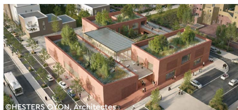
Construction d'une Maison de Quartier aux Pyramides – Evry-Courcouronnes (91) – 12 M€ HT
