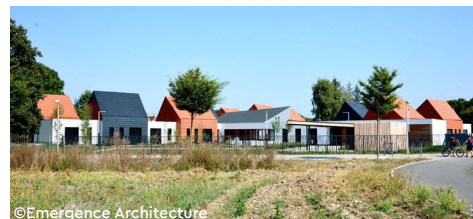
Construction d'une résidence pour personnes âgées Dinah Faust – Eschau (67) – 2,3 M€ HT
