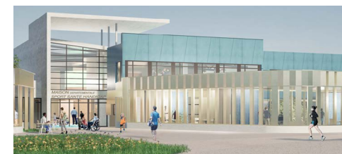
Réhabilitation-extension Maison départementale Sport, Santé et Handicap – Bazeilles (08) ©Erik Giudice
