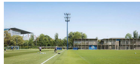
Construction d'un centre d'entraînement footballistique professionnel – Strasbourg (67) ©Lucquet Architectes
