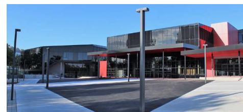
Rénovation du Palais des sports de Beaulieu Nantes (44) – ©AURA Architectes
