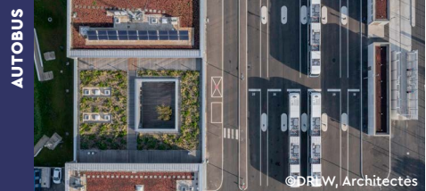
Site de maintenance et remisage Corbeil-Essonnes (91)
