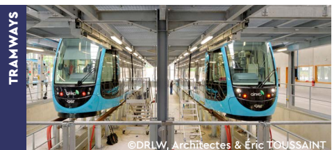
Centre de maintenance Besançon (25)
