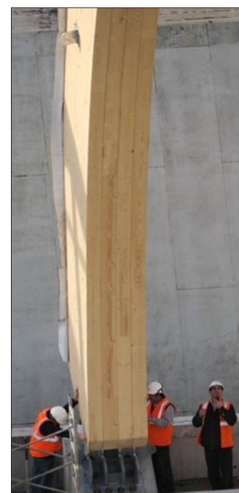
Encore un petit coup de masse pour positionner les 45 tonnes au centimètre près.
