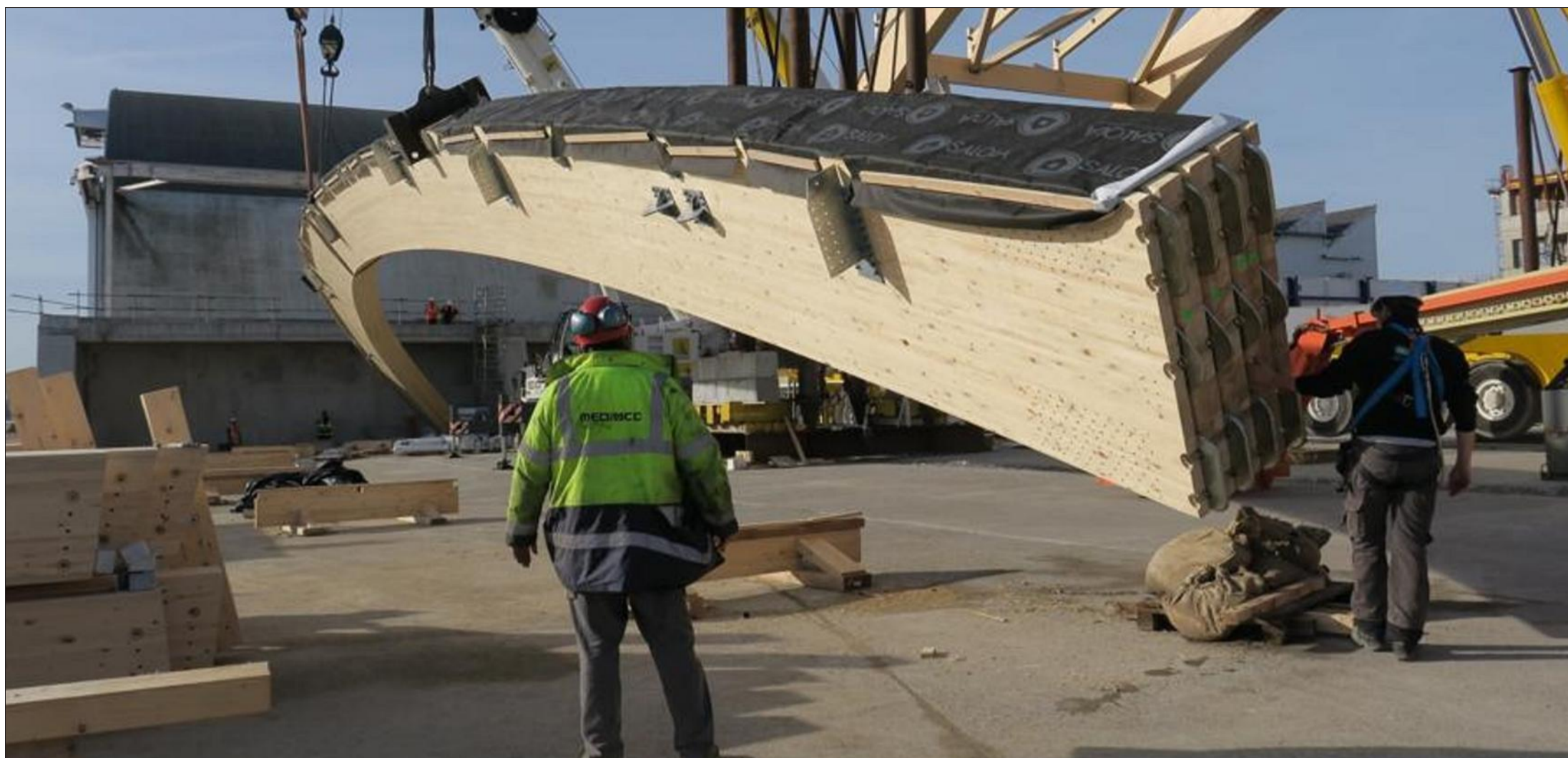
La demi-arche commence à s'élever tout doucement dans les airs. L'opération est très délicate et ne peut pas s'effectuer si le vent s'invite dans la partie.
